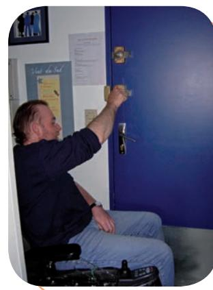
La porte d'entrée de 90 cm permet un passage en fauteuil roulant manuel et électrique. Le verrou a été descendu afin d'être dans les hauteurs de préhension des personnes en position assise, prises et interrupteurs se trouvent à proximité de cette porte.
