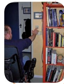
« **Les prises** d'alimentation électrique, les prises d'antenne et de téléphone ainsi que les branchements divers imposés par les normes et règlements applicables doivent être situés à une hauteur de  $H \leq 1,30\text{m}$  »
