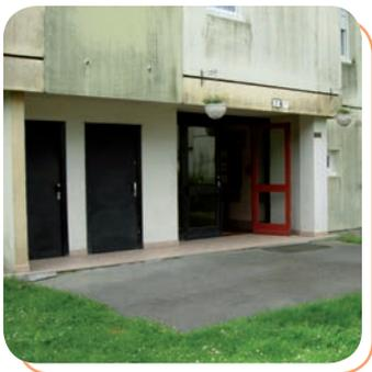
L'accès à la porte d'entrée a été adapté avec un contraste de revêtement et une différenciation des éléments architecturaux, l'indication du numéro de l'immeuble est facilement repérable.
