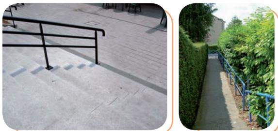
*La main courante est repérable visuellement par jeu de couleurs et permet un guidage permanent lors de la montée et la descente. La première et dernière marche ont une couleur plus foncée.*
