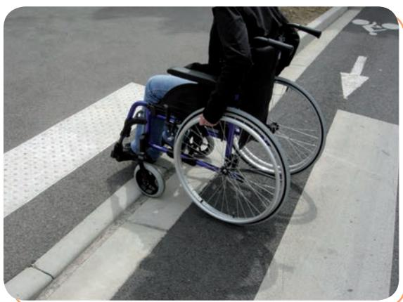
Détail de bordure dite « surbaissée » : « bateau » et « rampant » avec signal d'éveil permettant depuis la rue d'accéder au cheminement menant au logement.
