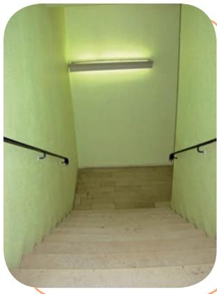
Cet escalier dispose d'un système d'éclairage satisfaisant, il est muni de mains courantes ou barres d'appui des deux côtés.
