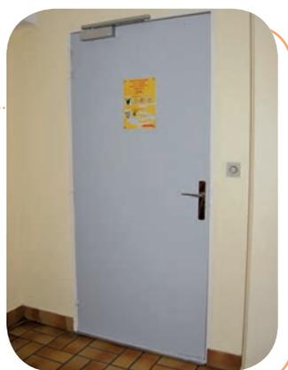
*La porte est équipée d'un système de fermeture automatique, l'effort nécessaire pour ouvrir la porte se mesure au niveau de la poignée.*
